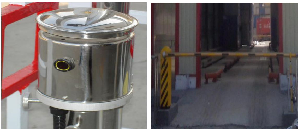
图 10-9 红外报警装置和挡杆
